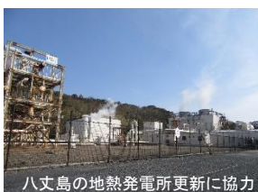
八丈島の地熱発電所更新に協力
