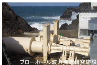
ブローホール波力発電研究施設
